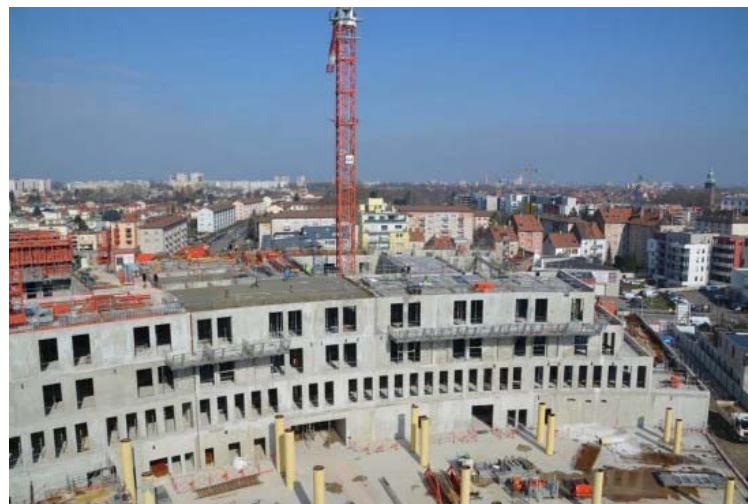
© Bouygues Bâtiment Nord-Est - Le gros œuvre doit achever en septembre prochain.
