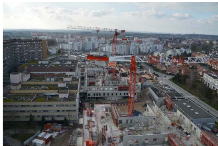
© Bouygues Bâtiment Nord-Est - Le nouvel Institut régional du cancer et le plateau médico-technique locomoteur s'insèrent au milieu de blocs opératoires et de réanimation.
