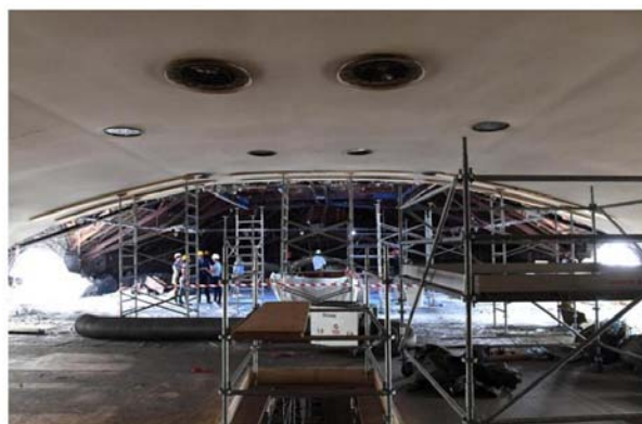
Sous la voûte du palais des fêtes, un important chantier de remise aux normes anti-incendie est en cours. PHOTOS DNA - LAURENT RÉA
