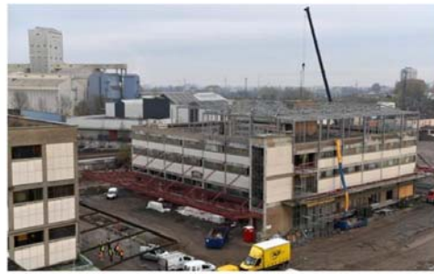
Le futur bâtiment des réserves des musées de Strasbourg qui a servi de site de stockage de matières premières et de produits alimentaires.
