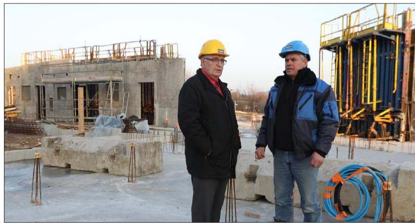
L'association des Papillons blancs continue sa modernisation grâce à deux nouveaux sites, en cours de construction. Primo Frare, président, visite celui situé au Parc des Collines de Didenheim, avec le responsable du chantier. Photo L'Alsace/Darek Szuster
