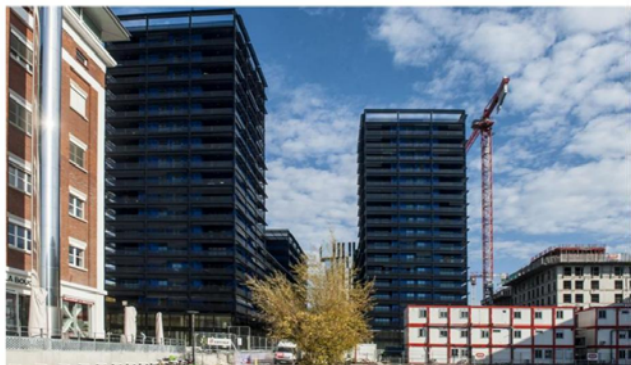
À côté du bâtiment des Docks (à gauche) surgissent deux cygnes noirs. La troisième tour est en construction sur la droite.
