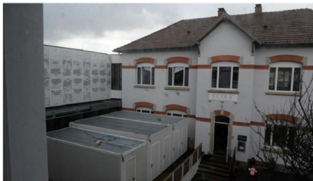
L'ancien bâtiment et une partie de la nouvelle façade qui doit « jouer » avec le soleil et la lumière. Pour l'heure, la cour des petits est encore amputée par les sanitaires provisoires.
