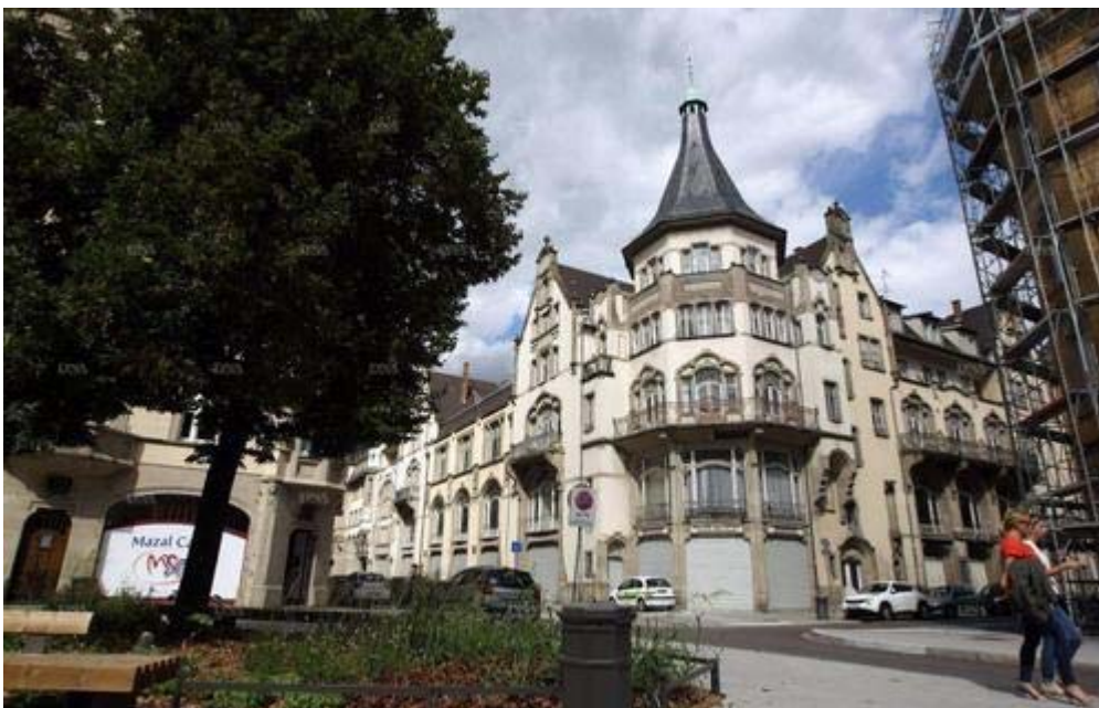
Le nouveau chantier concernera le bâtiment de 1903. PHOTO DNA - Laurent RÉA
