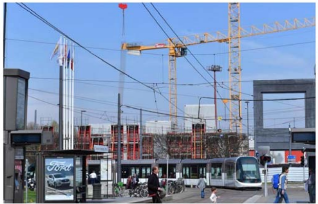
Le chantier est situé à l'intersection de l'avenue Schutzenberger et de la rue Jean-Wenger-Valentin. PHOTO DNA - JEAN CHRISTOPHE DORN
