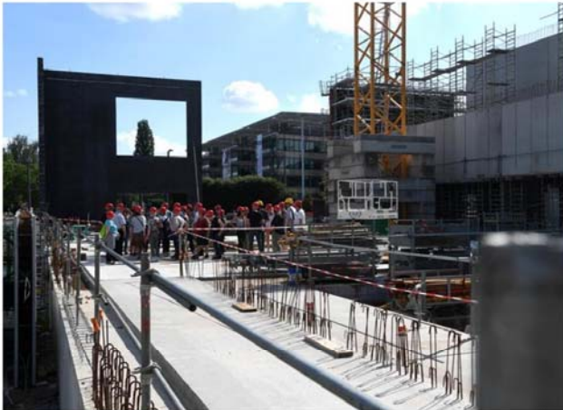
En fin de parcours, un des trois groupes guidés, hier, sur le site du nouveau Maillon. PHOTOS DNA - LAURENT RÉA
