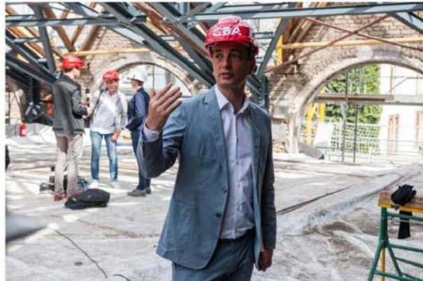
Les grandes baies vitrées (derrière le premier adjoint Alain Fontanel) sont conservées et la charpente a été renforcée pour soulager l'existante et supporter des éléments scéniques.
