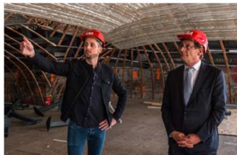
L'armature et les différentes couches de l'isolation de la voûte sont installées, a pu constater l'adjoint de quartier Robert Herrmann.
