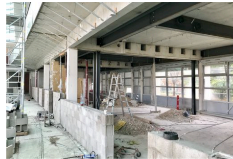
Les planchers de l'étage ont été renforcés par des poutres métalliques.
