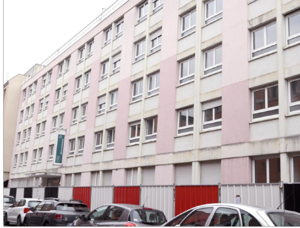
La Cité universitaire du numéro 13 de la rue de la Somme, dans le quartier du Conseil des XV, va faire l'objet de gros travaux de réhabilitation. Photo DNA/Franck KOBÉ
