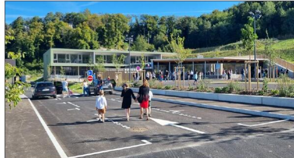
Le pôle scolaire et périscolaire Robelin a été construit sur l'emprise de l'ancienne caserne de gendarmerie mobile Robelin et les travaux se sont achevés en extremis pour la rentrée ! Photos DNA/N.B.-G.
