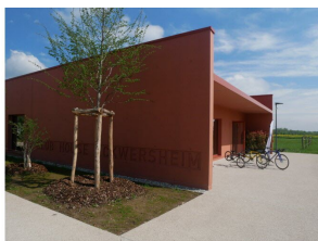
Le nouveau bâtiment construit par le cabinet d'architecture Thierry Rey et Olivier de Crecy. Photo G.P.
